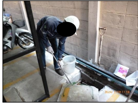
น้ำทิ้งหลังจากออกจากระบบบำบัดน้ำเสีย ชุดที่ 2
